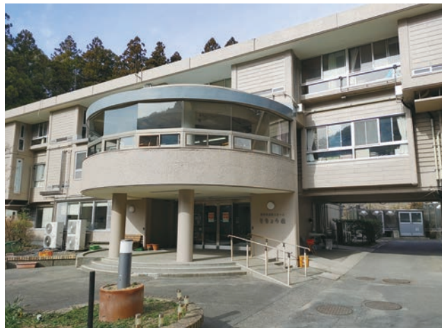
外観（外壁塗装後）
